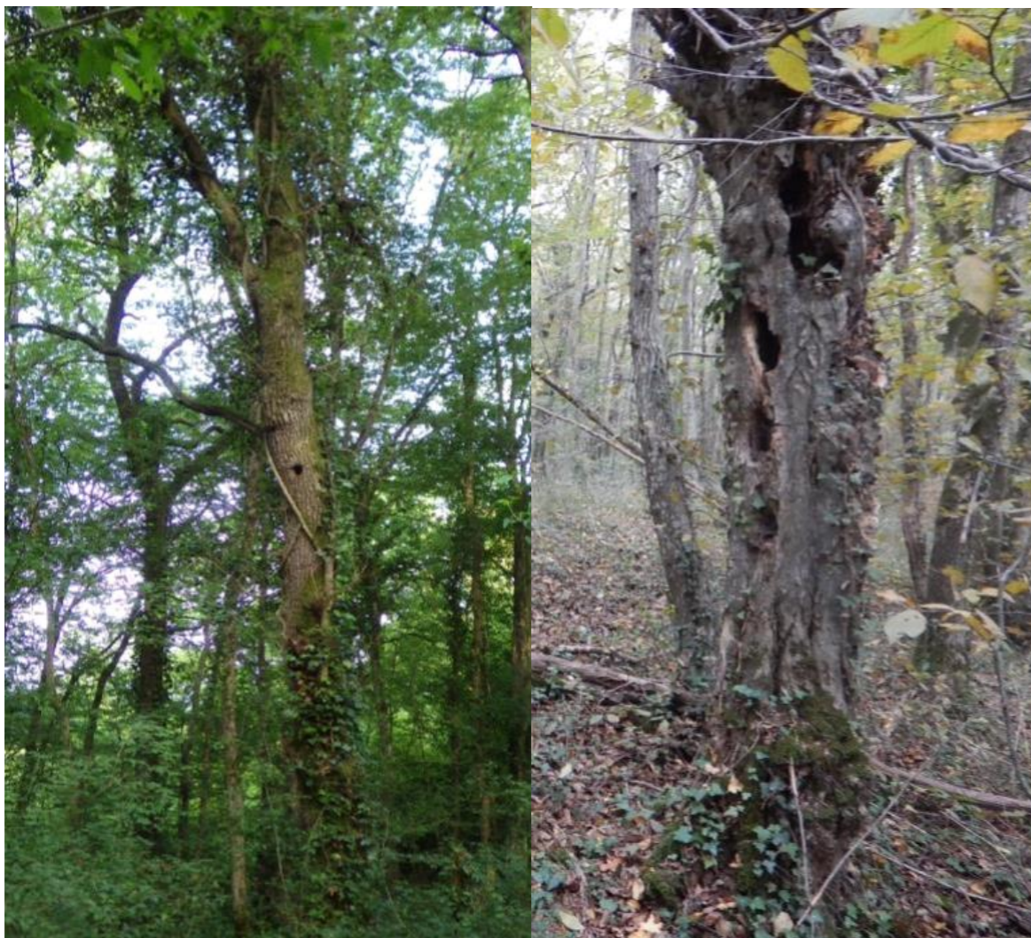
Figure 72. Arbres présentant des cavités susceptibles d'être colonisées par des chauves-souris en gîte (photo prise sur site)
